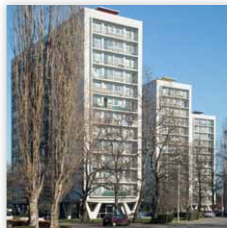
Cité de Droixhe (Liège), maître de l'ouvrage « La Maison liégeoise », architectes Groupe E.G.A.U. (Charles Carlier, Hyacinthe Lhoest, Jules Mozin).
