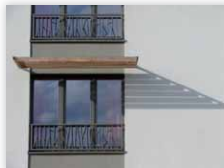
Détail d'un brise-soleil © Atelier de l'Arbre d'Or
