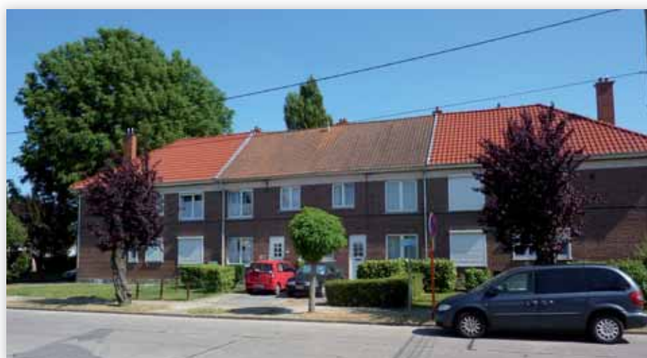
Mons, cité du Joncquois : ensemble avec 2 duplex aux extrémités et 2 maisons « classiques » au centre
