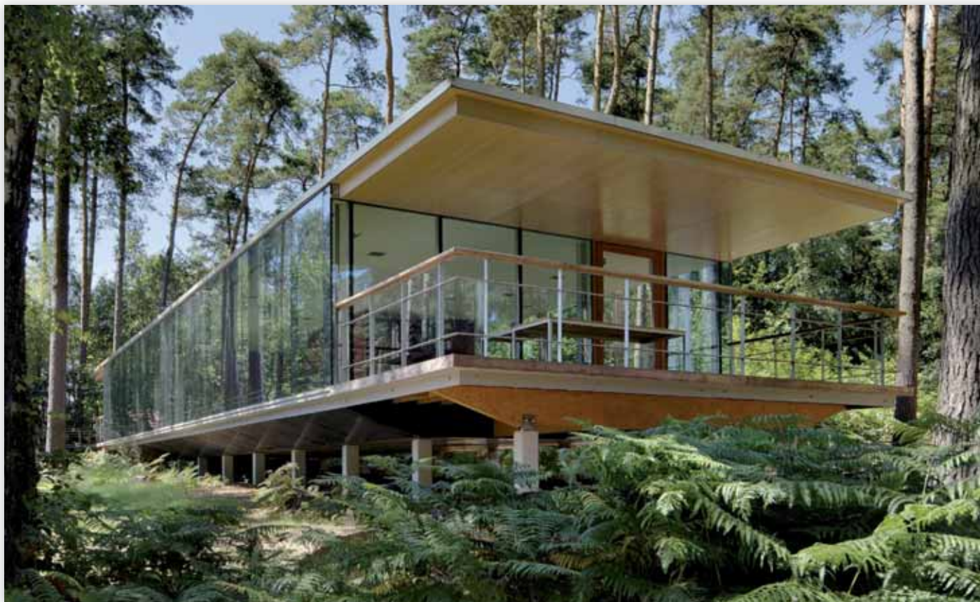
Nouvelle extension de la Résidence Lennox (Artau architecture)
