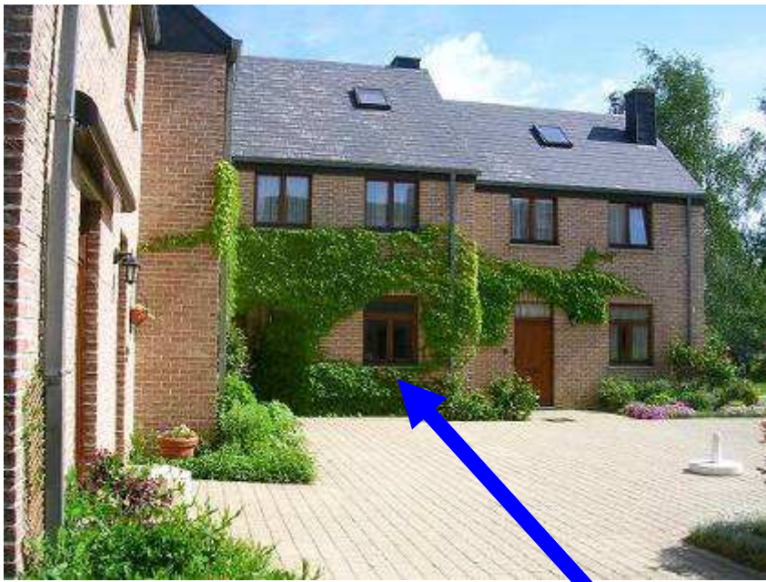
Le Petit Béguinage (Louvain-La-Neuve), espace collectif intégré au bâti
