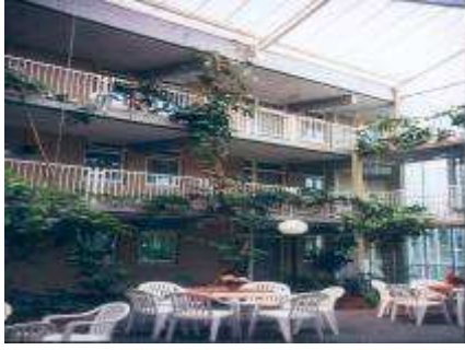
Coursives de distribution à Kruistraat (Pays-Bas)
