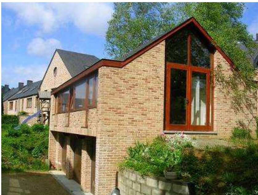
Lauzelle (Louvain-La-Neuve) avec garages en sous-sol
